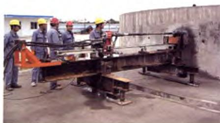
图4 钻机机架结构
