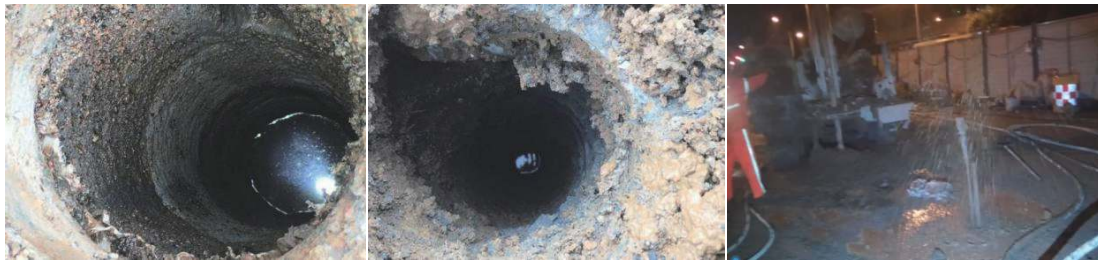
(a) 钻孔内揭露地下水 (b) B4-3 施工 6 m 处, B3-4 串喷水
