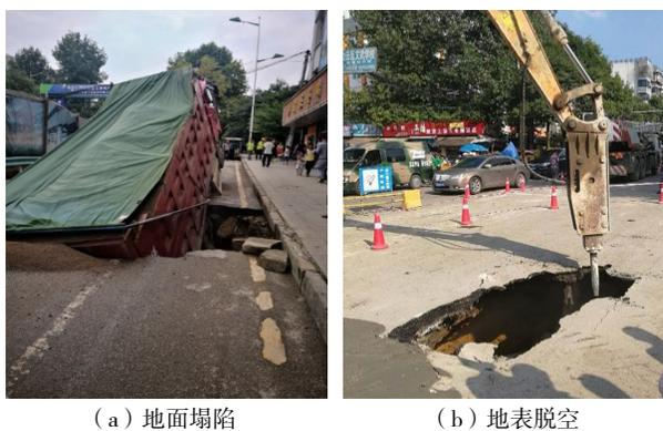
图 2 七机路口站—云峰路站区间隧道地面塌陷与地表脱空
