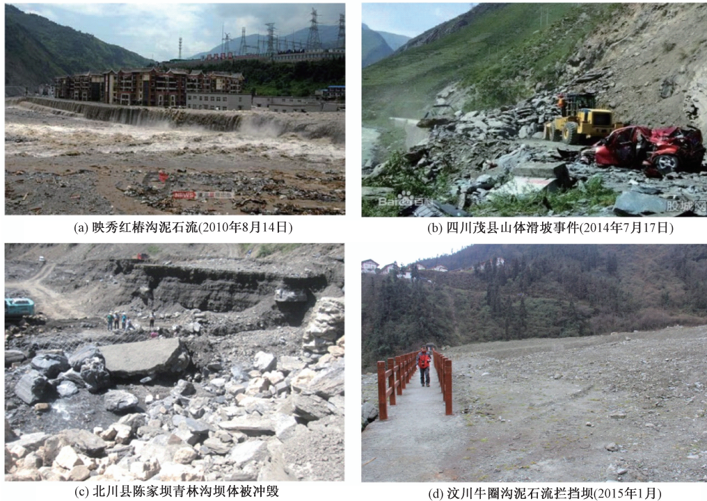
图4 汶川震后几年来的典型地质灾害及防治工程破坏实例
